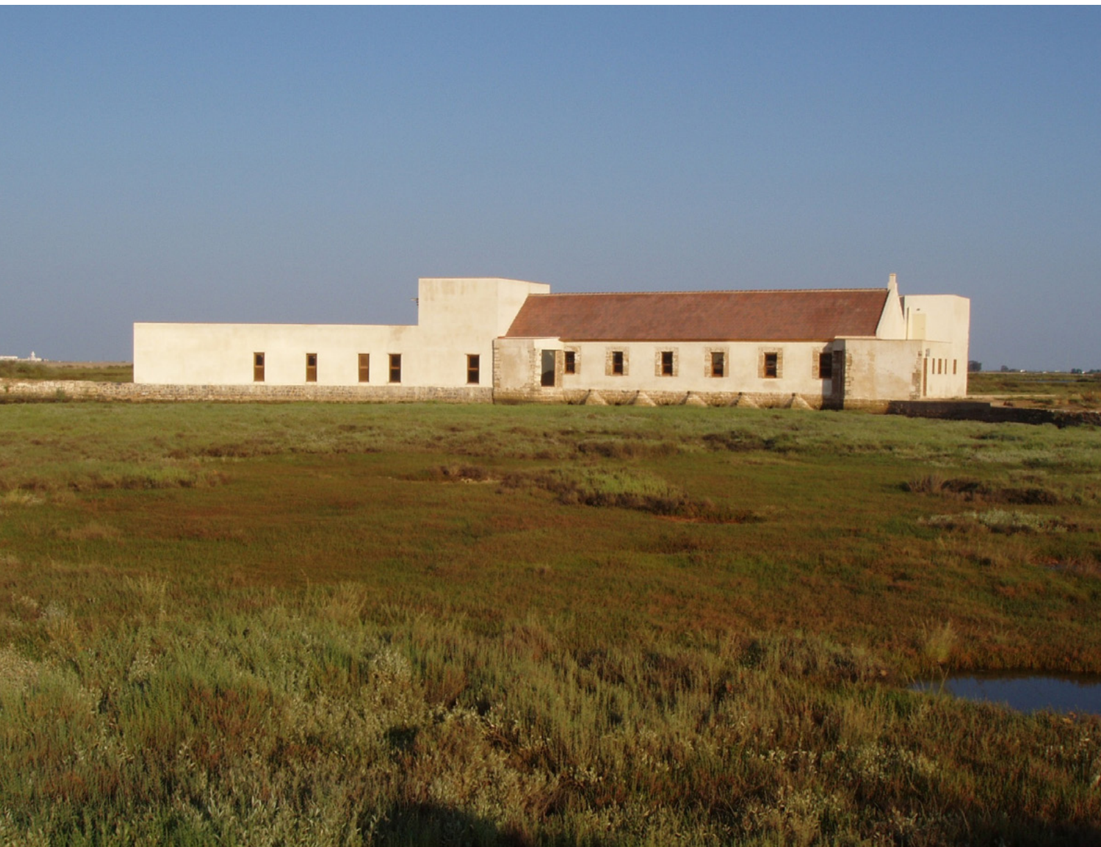
Molino mareal El Pintado reconstruido | foto Patxi Serveto (Ayamonte, 2007)
