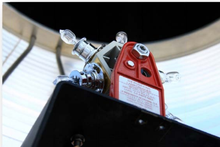
Cambiador automático de bombillas de este faro
