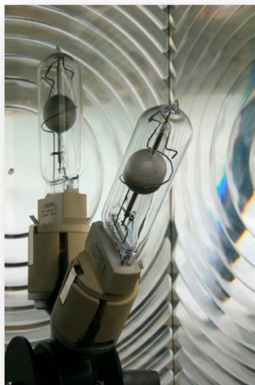
Interior de la óptica y lámparas del faro
